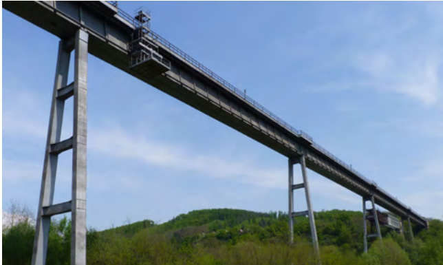
Obr. 26 Trámový nosný prvek, Ivančický viadukt (Wikipedie)
