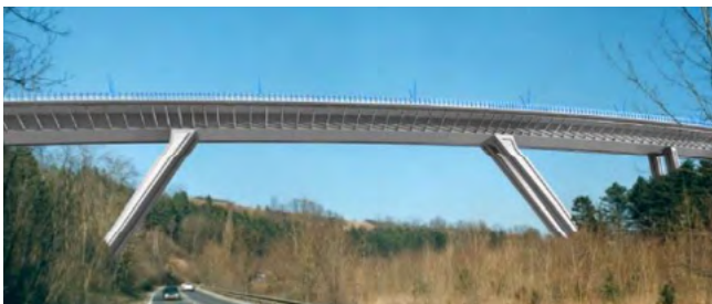
Obr. 27 Trámový silniční most
