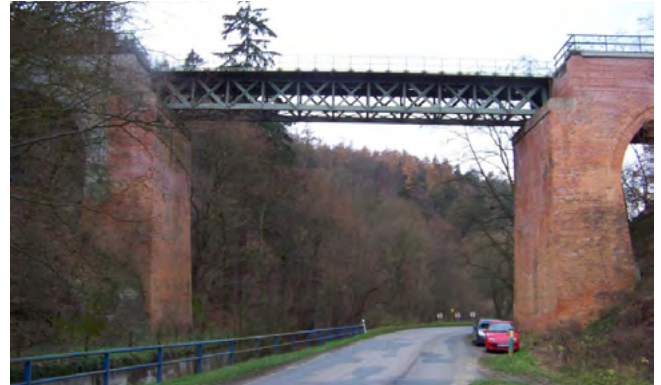
Obr. 28 Příhradový most – prostý nosník – na kamenných obloukových podpěrách
